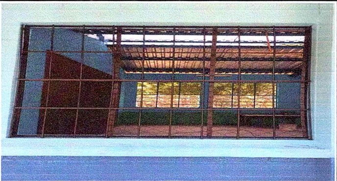
Foto 3: SUSTITUCION DE VIDRIO QUEBRADOS POR NUEVOS
