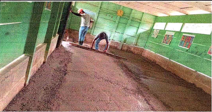
Foto 5: COLOCACION DE PISO DE AULA
