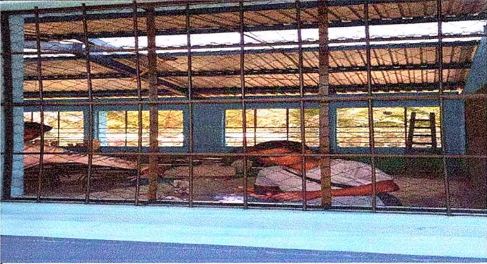
Foto 2: COLOCACION DE VENTANAS NUEVAS CON BALCON
