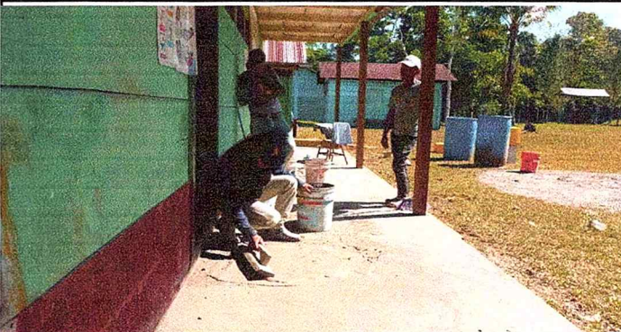
Foto 4: INSTALACION DE PATIO DE PISO
