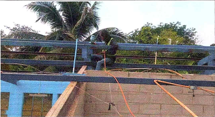
Foto1: DESTECHADO DE LAMINAS EN EL EDIFICIO ESCOLAR, POR LAMINAS TROQUELAS.
